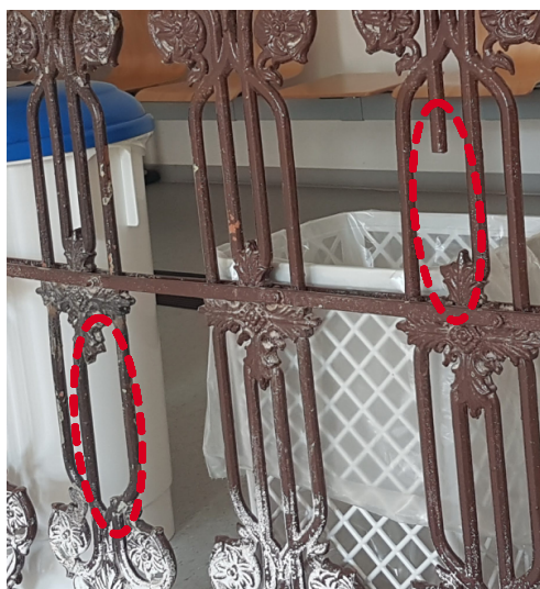
DEFEKTY - ZÁBRADLÍ CHODBY:
